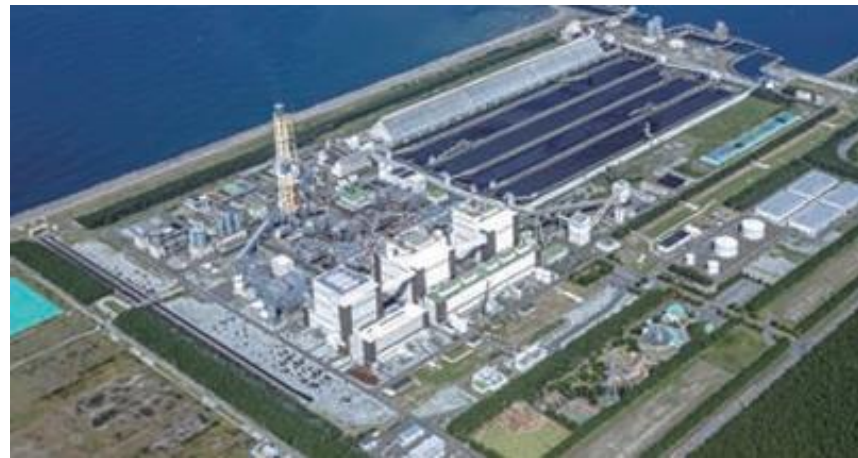
火力発電所も見学可能
