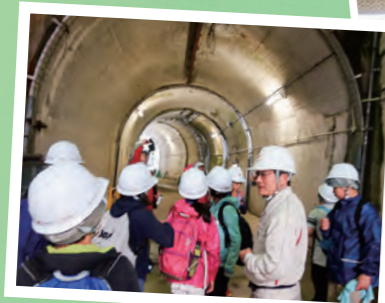
安全のためヘルメットをかぶりエレベーター2本を乗り継いでダムの最下部へ。巨大な地下発電室です。
